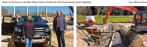
Direkt im Anschluss an die Wun-Pellets-Fabrik entsteht die 4200 Quadratmeter große Siphalle. An der Stelle, auf der das Sägewerk gebaut wird, stehen die Handwerker die die Gasleitung für die Pellets-Fabrik auf. Im Sommer 2021 sollen die ersten Pellets-Fabrikanten in Wunsiedel ans Werk gehen.
